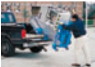
搬入・設置作業
